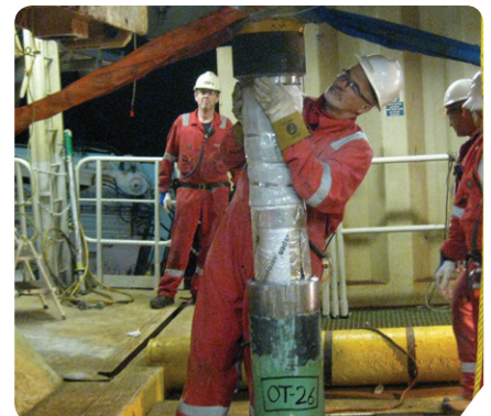
Welding ILS to pipeline
